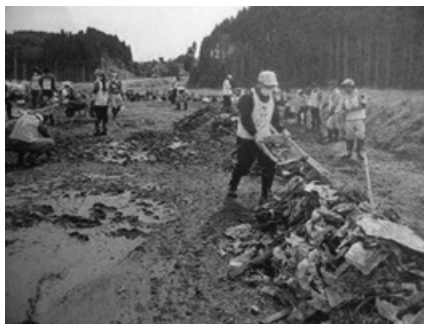
瓦礫処理作業
